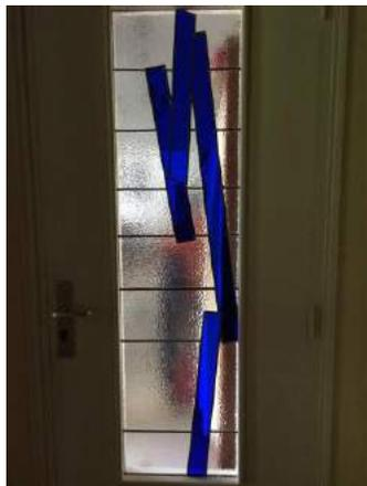
Dans le **sertissage au plomb** (depuis le Moyen Âge en Occident), de petits morceaux de verre colorés sont coupés aux gabarits suivant un plan précis et assemblés dans une résille de plomb. Les verres peuvent être peints et cuits à 600°C pour vitrifier la peinture (constituée de poudre de verre et d'oxyde métallique) sur la surface.
