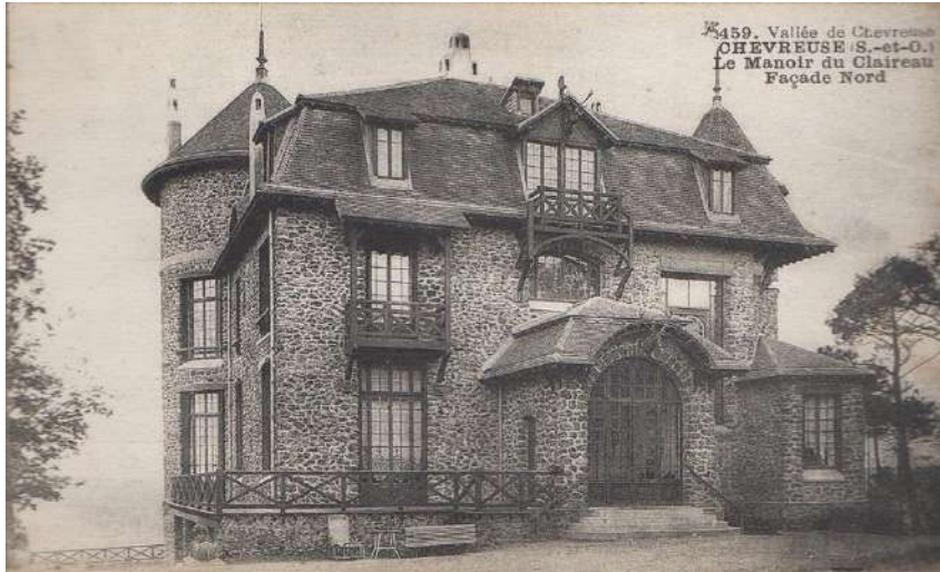
Façade nord du Château
